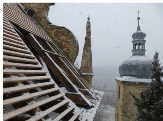
Odkryté konstrukce při opravách u štítové zdi.
